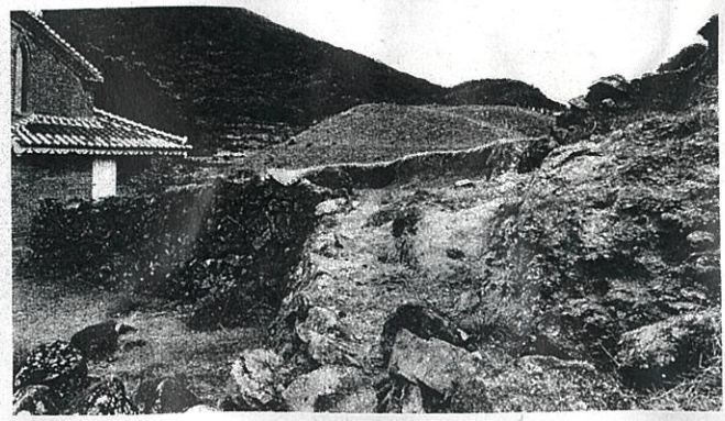
旧野首教会近くで獣害と風水害が重なって崩落したとみられる石積み(10月25日、長崎県小値賀町・野首島)
